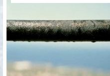
Figura 29. Tubería punto o exudante.
