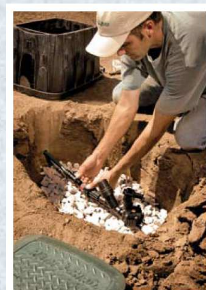
Instalación de arquetas
